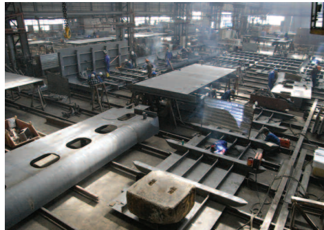
Fra byggingen av HiLoad DP 1.
